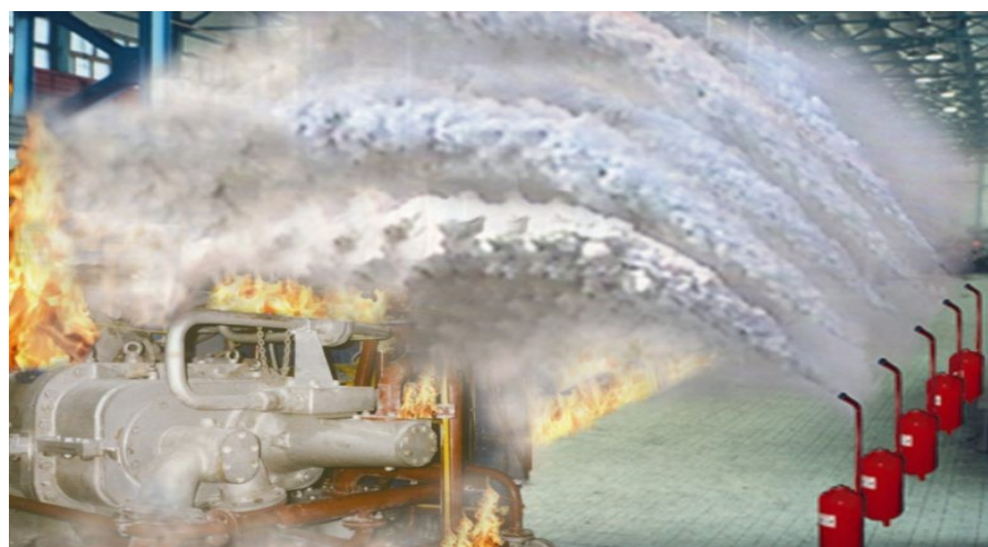
Сурет 1.14 - Отты сөндірудің беттік түрі
