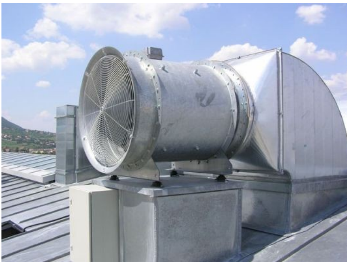
Сурет 2.14 - Түтін шығару вентеляциясы
