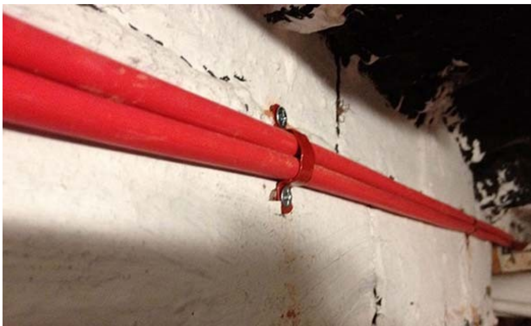
Сурет 1.18 - Өрт сигнализациясында кабельдің қолданылуы
